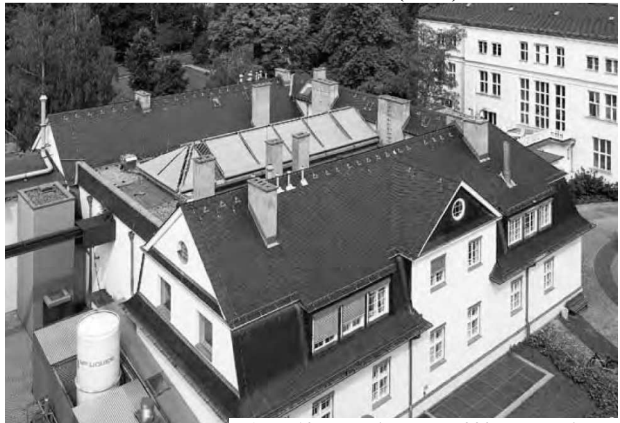
Abb. 10 Maschinenhalle 2005 restauriert Man sieht den Lastenseilzug linker Hand, vor dem das Werkstattmitarbeiterbild
